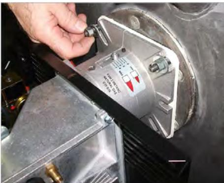
7) Зафиксировать горелки на котел;
