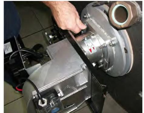
6) Зафиксировать горелки на котел;
