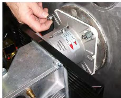
6) Зафиксировать горелки на котел;
